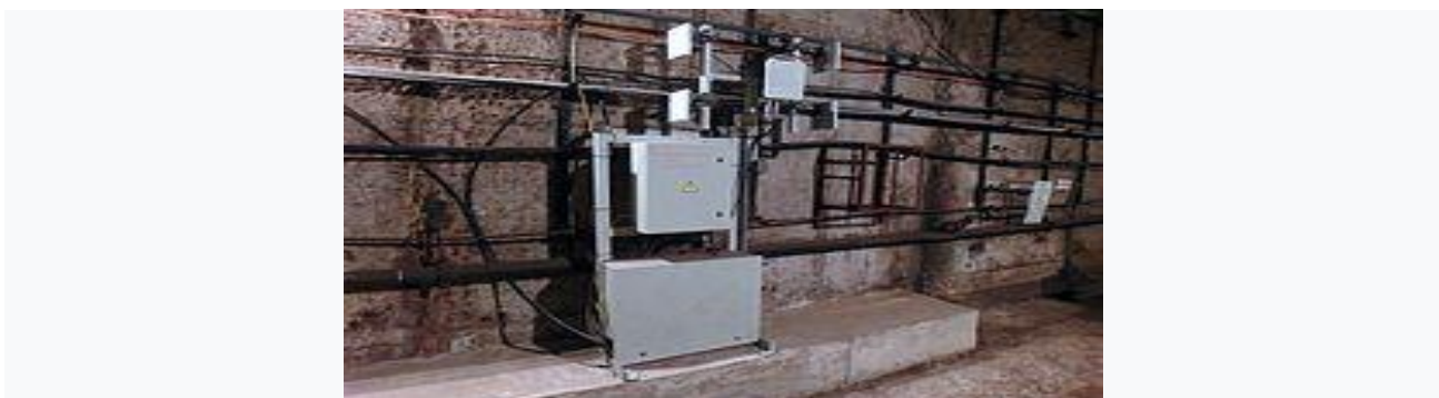
Сурет 2.8 - «Максим Телеком» компаниясы ұсынған метрополитен туннельдеріндегі Wi-Fi-антенналары
