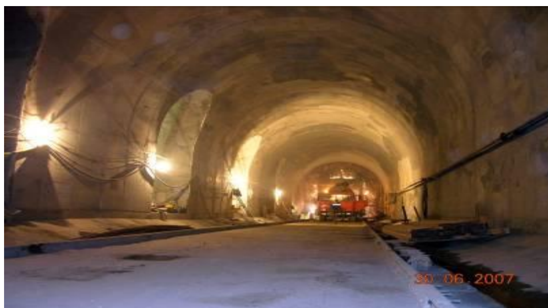
Сурет 1.2 – Бүйірлік бекет тоннелдерін төсеу
